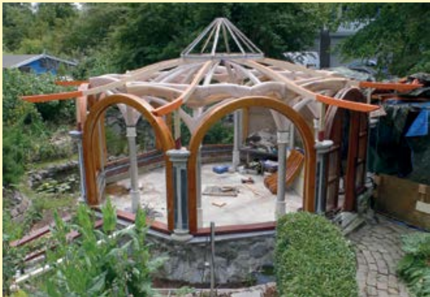
2015, de tempel in aanbouw
